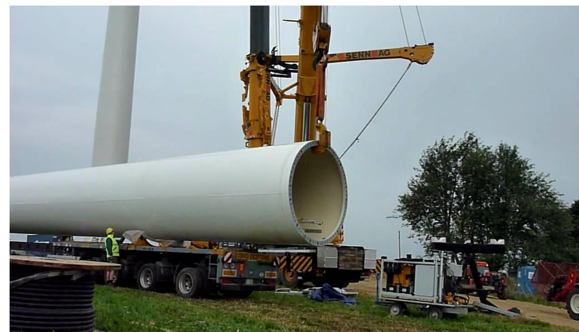
Figure 132 : Assemblage d'une section de tour
