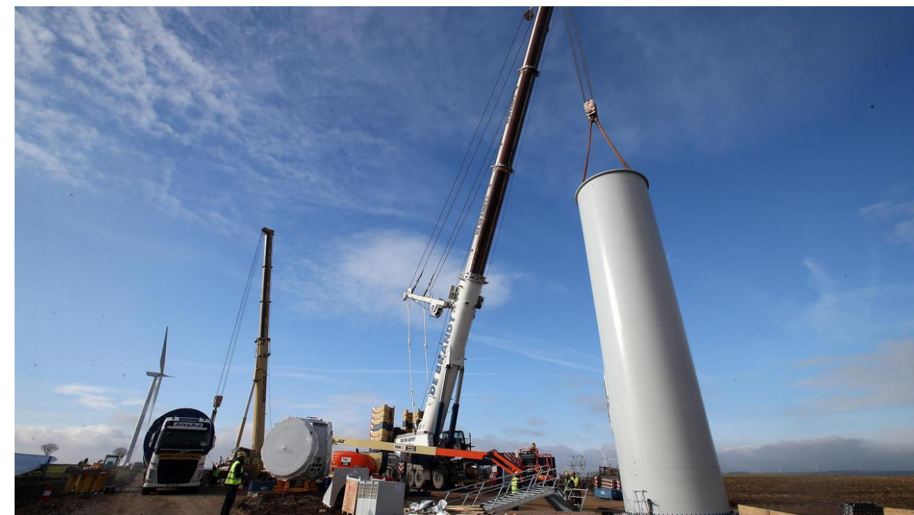
Figure 141 : Levage d'une section de mât
