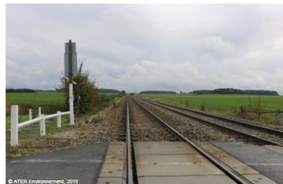
Figure 99 : Passage à niveau à l'est de Crépy
