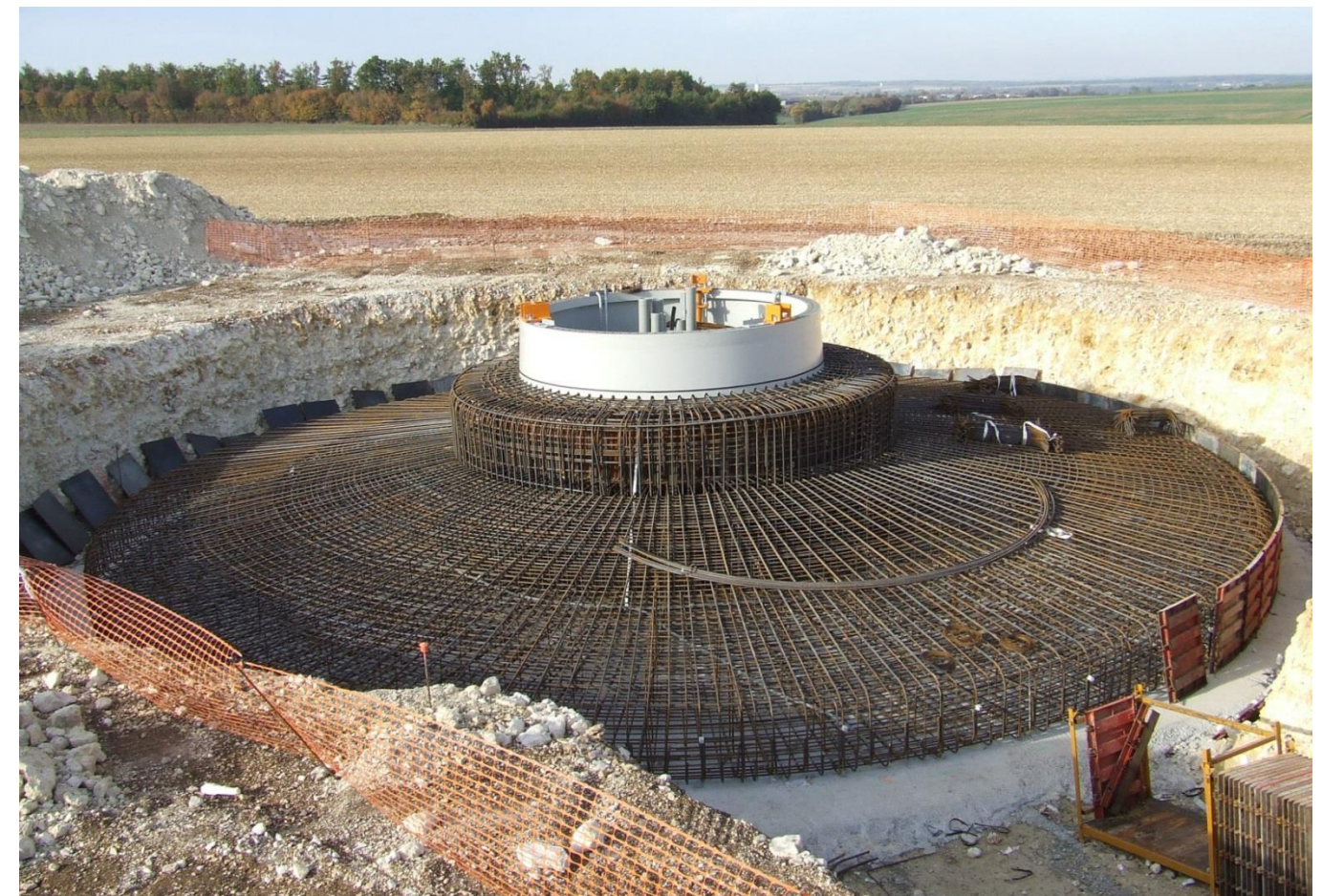
Figure 140 : Ferrailage d'une fondation
