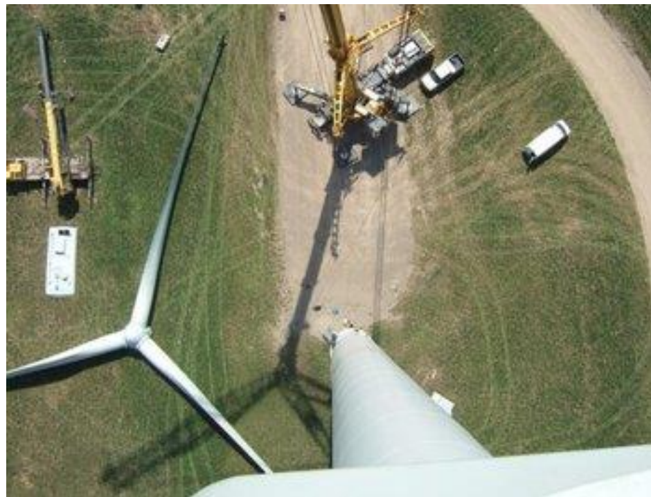
Figure 139 : Aire de grutage
