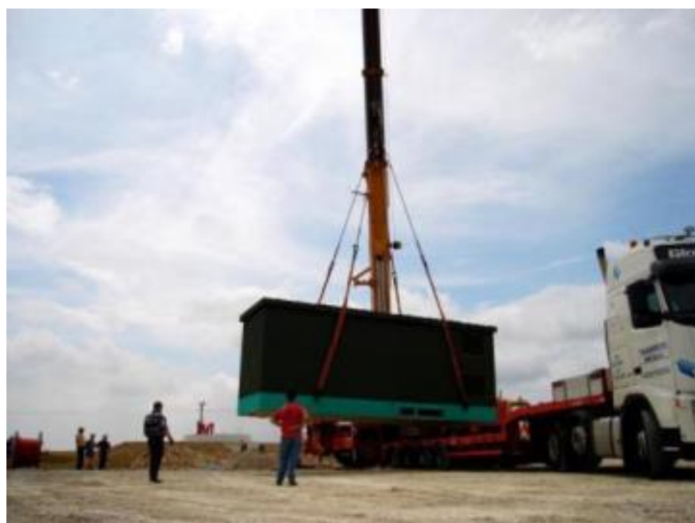
Figure 134 : Pose d'un poste de livraison
